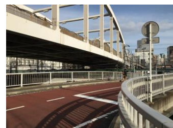
元平沼橋（下） と 平沼橋（上）
