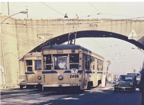
市電が通った頃の霞橋
